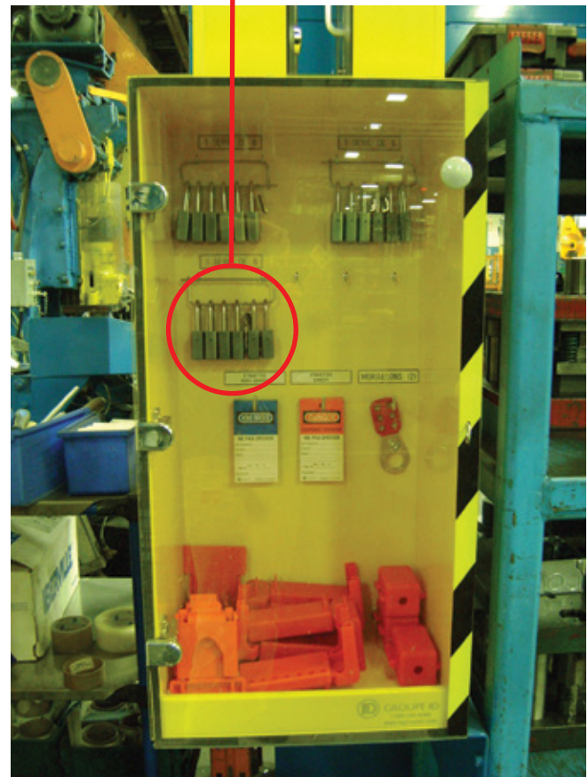
EXEMPLE D'UNE STATION DE CADENASSAGE
