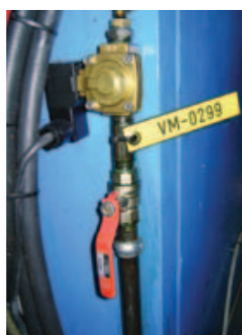
Exemples de dispositifs d'isolement : sectionneurs électriques et valve pneumatique
